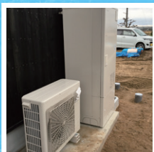
オール電化工事
